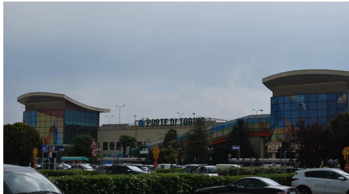
Imm. 24 - Centro commerciale Centro commerciale 'Le Porte di Torino' (Crediti @Urban Lab)
